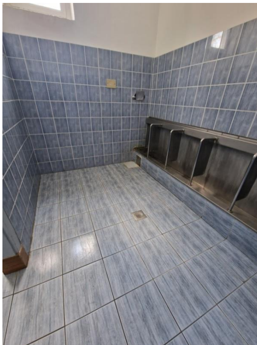
Fotografija 2 Prizemlje, Sanitarni blok M.
