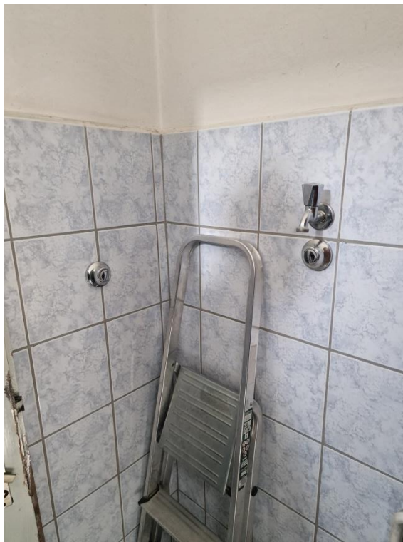
Fotografija 7 Kat, Sanitarni blok djelatnika
