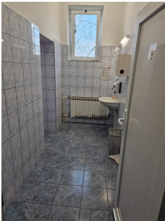
Fotografija 4 Kat, Sanitarni blok M.
