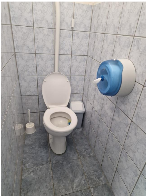
Fotografija 8 Kat, Sanitarni blok djelatnika
